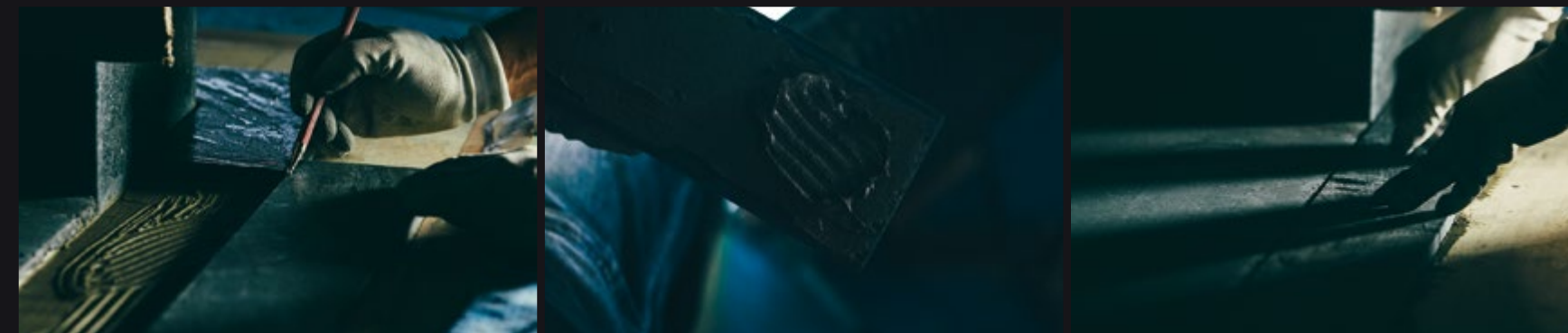
石貼り…15cm幅に整えられた玄昌石は、床一面に敷き詰められるウィルトンカーペットの柔らかい質感を引き締めるべく据付られ、床の端部を縁取る。 Stone fixing: a prepared slate (Genshoseki) of 15 cm in width is installed in order to harden the feel of the soft Wilton carpets covering the whole floor surface and to frame the edge of the floor.
